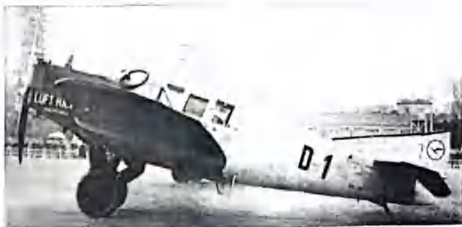
图 1.33 容克斯 F13 型飞机是世界上第一种全金属结构的民航飞机
